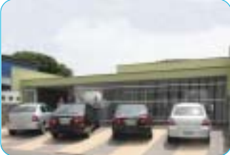
Fachada da nova Delegacia Regional de Piracicaba, à Rua do Rosário, nº 2184
