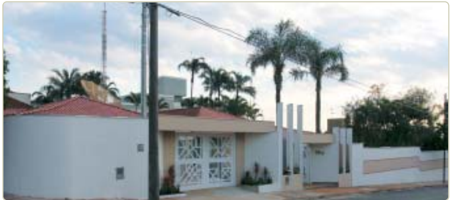
Acima, vista geral do lado externo da nova Regional de Araraquara Abaixo, Ribeiro Machado vistoria obras de São José do Rio Preto.
